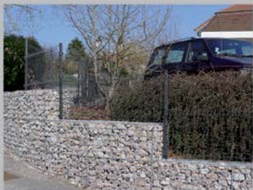
MURS GABIONS & CLÔTURE RIGIDE
